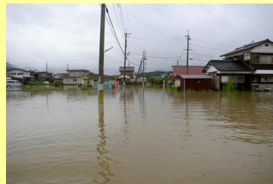
鴨原団地入口の浸水状況
