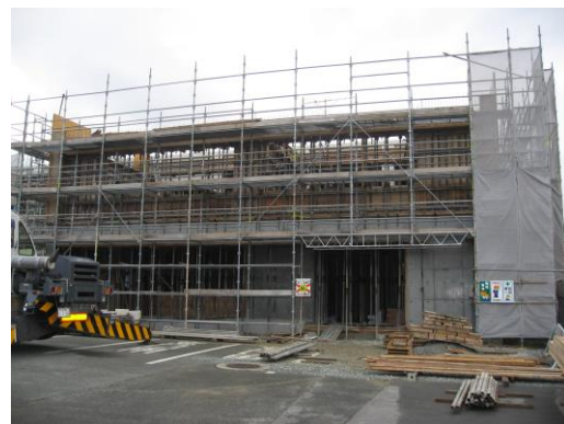
【増築部分の工事状況】
