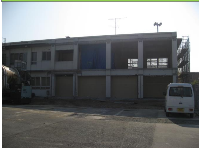
「10/21 工事中の交流センターの様子」 増築部分の壁が取り除かれました！
